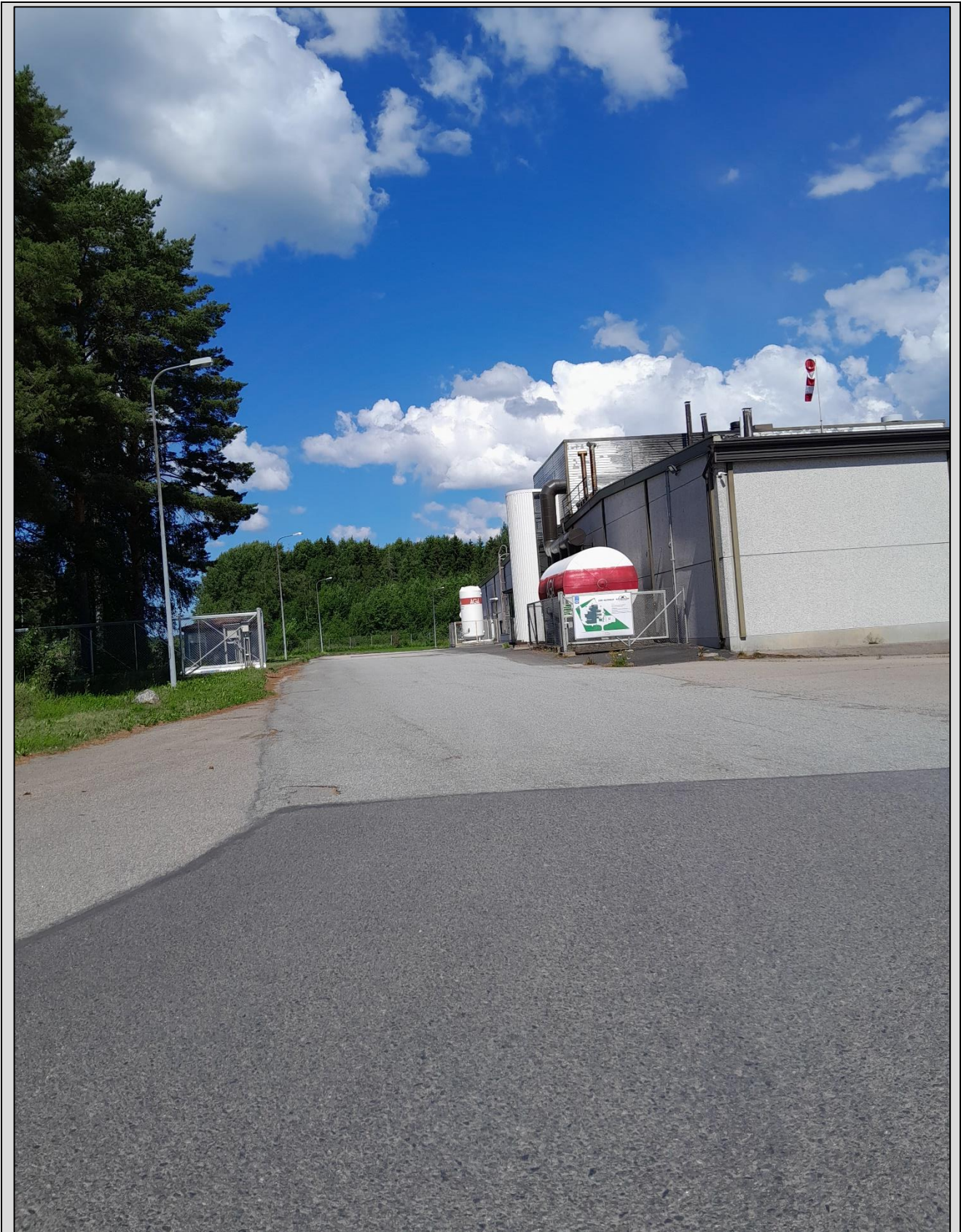
Kuva 6. Länsi-Kalkkuna Oy:n tilat Uusikylän pohjavesialueella.
