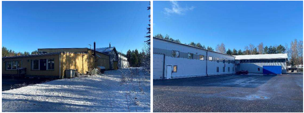
Teollisuusrakennuksia suunnittelualueen kiinteistöllä 783-401-58-25 Jarila.
