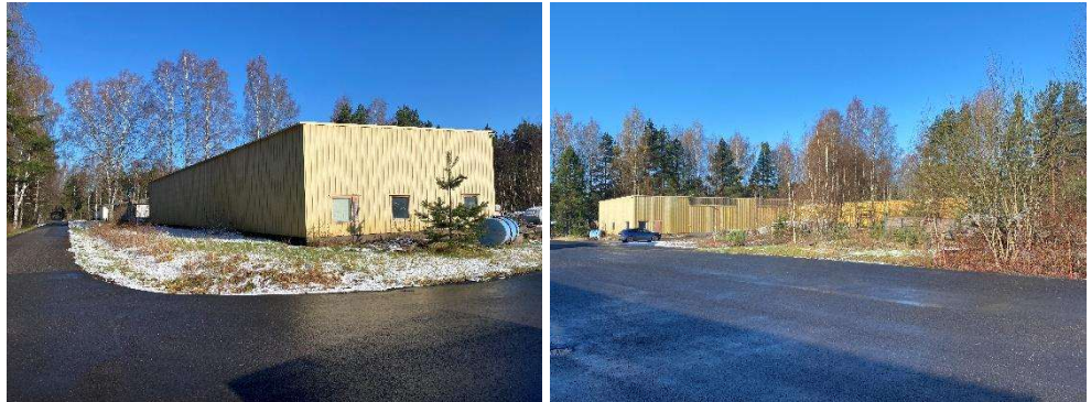
Teollisuusrakennuksia suunnittelualueen kiinteistöllä 783-401-58-4 TEOLLISUUS-TIE III.
