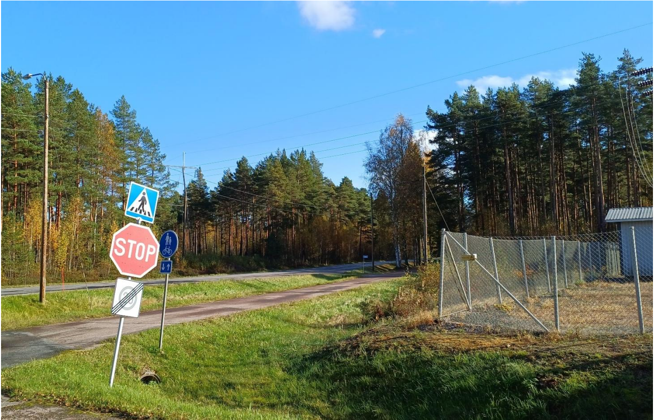
Kuva 2. Voimajohtoreitin alkupää Euran sähköasemalta itään päin. Kuva: Paula Salonen, Envineer Oy.
