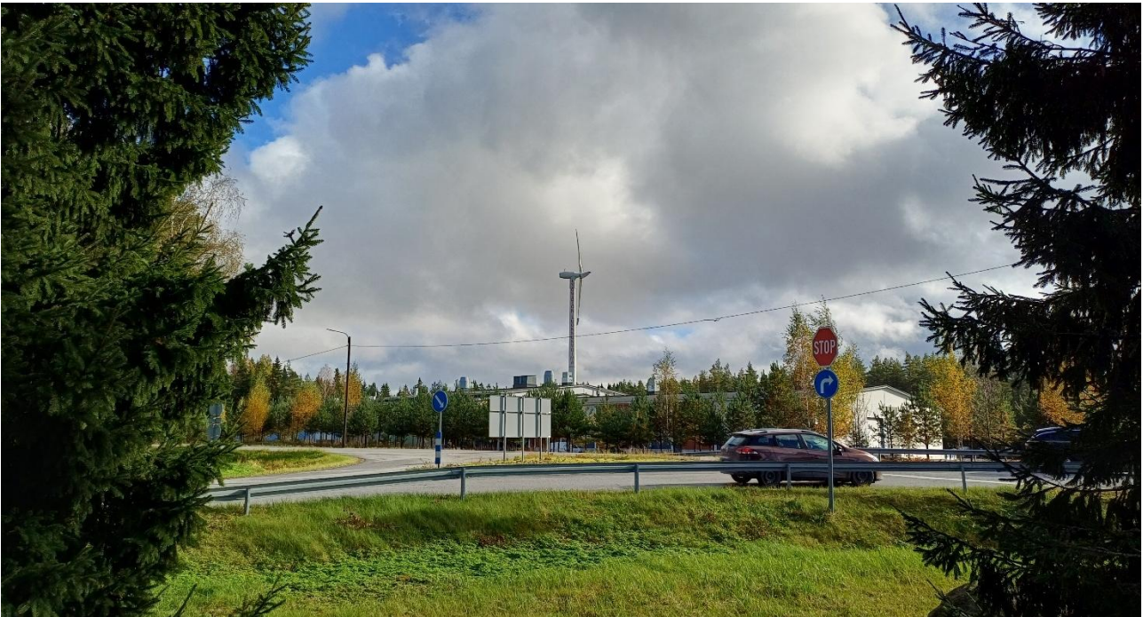
Kuva 14. Biolanin pääkonttorin eteläpuolella on yksittäinen tuulivoimala.
